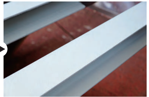
⑥施工完了
